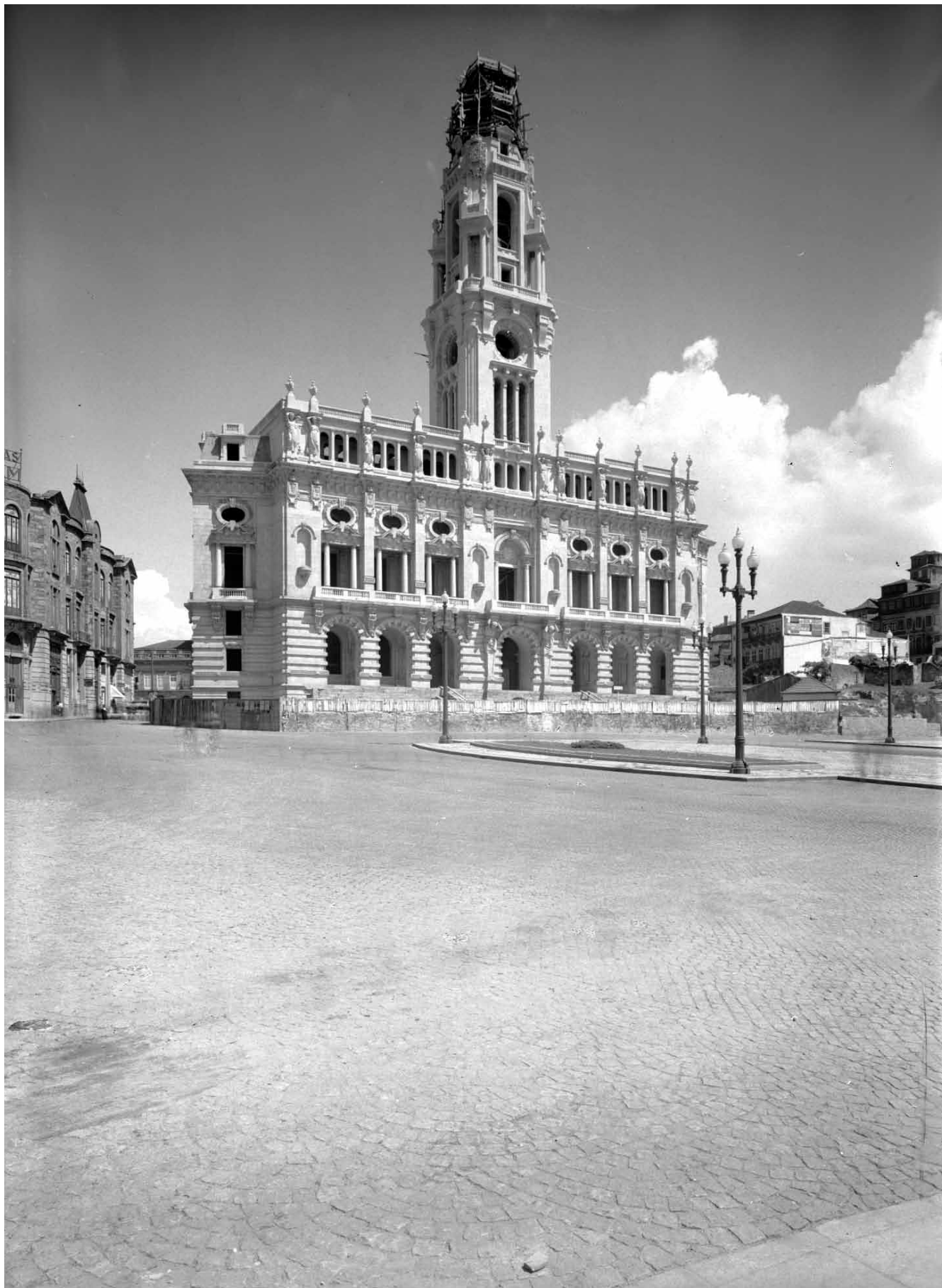
Vista geral da fachada principal, vendo-se ainda os andaimes para a construção do coroamento original da torre (1937-1938)
