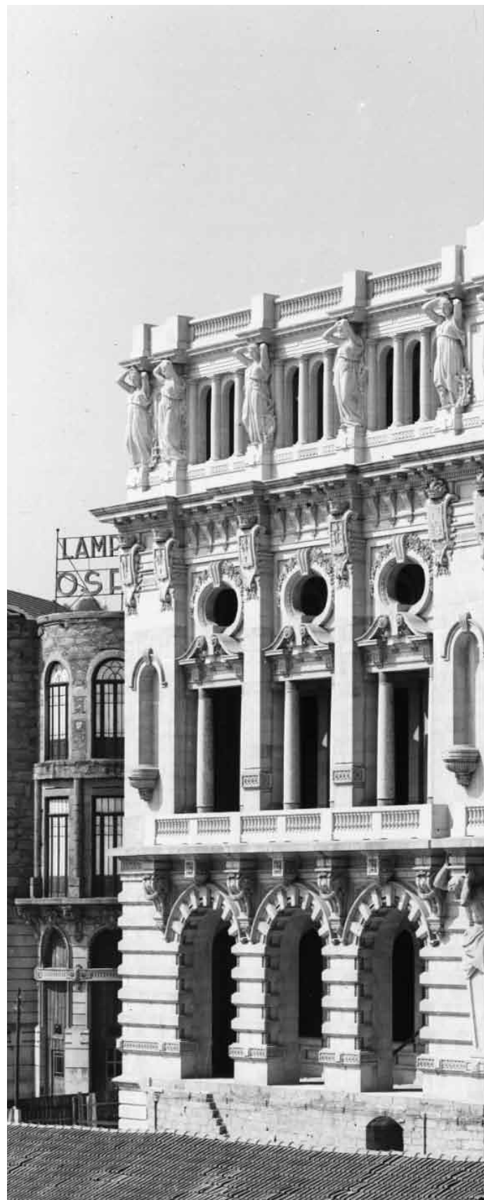
Fachada principal dos Paços do Concelho do Porto em construção (década de 1930)
